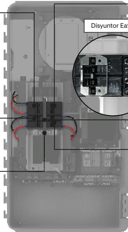
Figura 2: Cableado del interruptor de apagado del sistema
